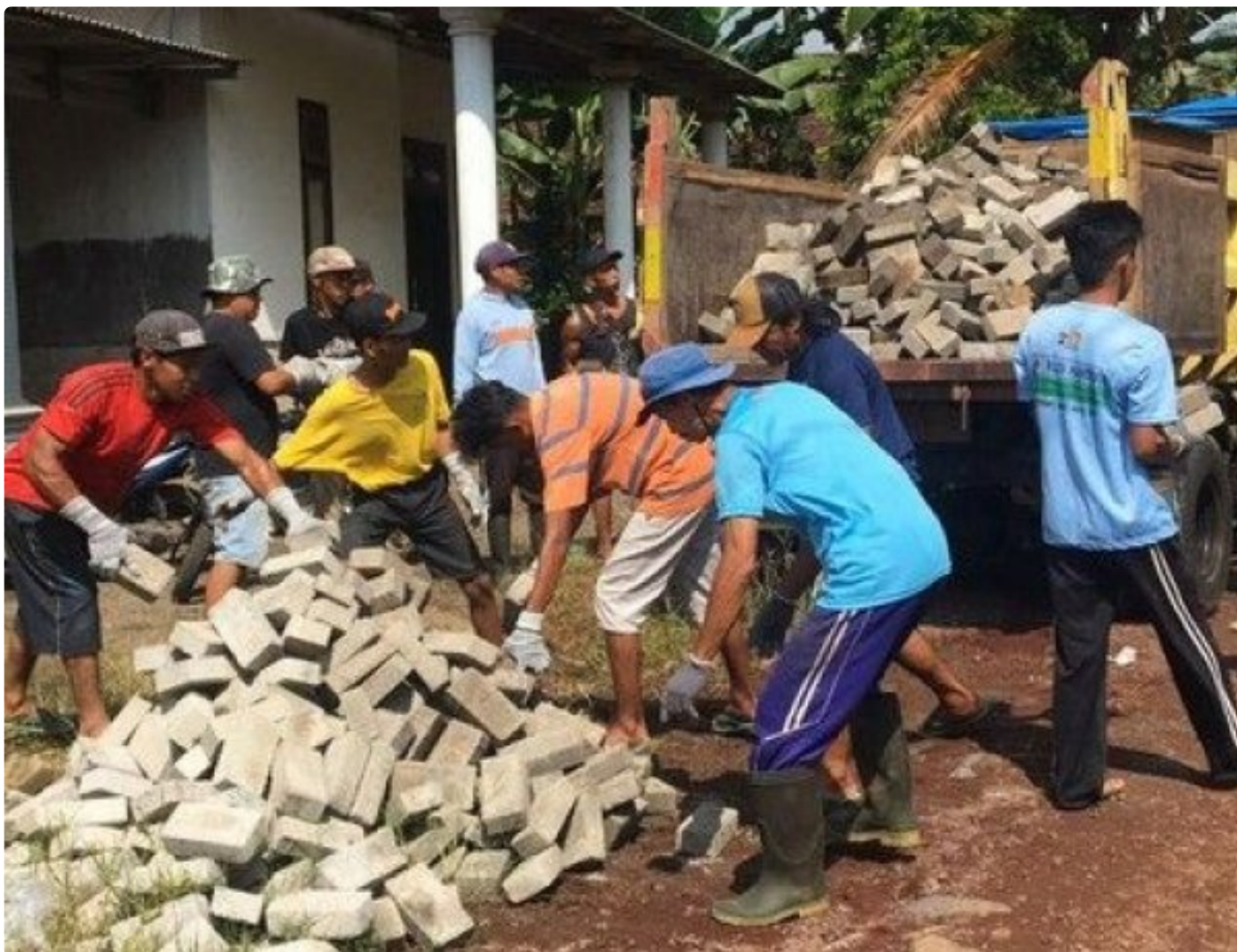
Paving block pemberian dari salah satu caleg yang kalah diangkut lagi menggunakan truk
